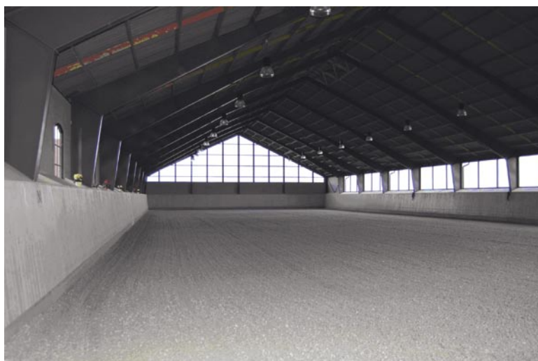
Bild t h: Ridhuset med stålstomme har stora glaspartier för att kunna släppa in mycket ljus.
